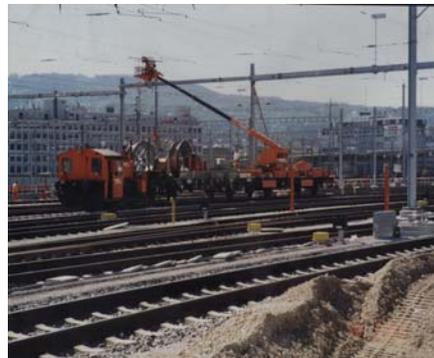
**Gelenk-Teleskopbühne für Fahrleitungsbau mit 550 kg Korblast**
